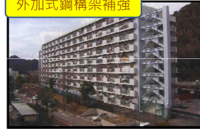
外加式鋼構架補強
