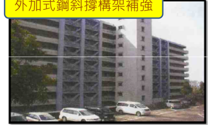
外加式鋼斜撐構架補強
